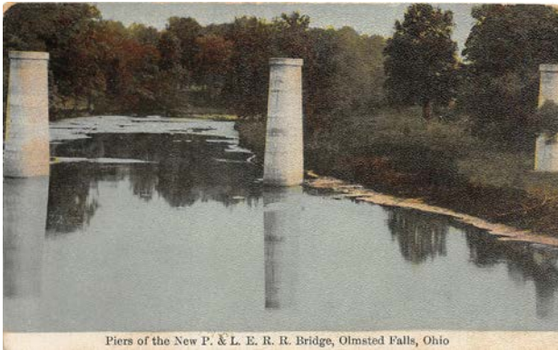
Piers of the New P. & L. E. R. R. Bridge, Olmsted Falls, Ohio
